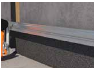
Upevnění základacího profilu.
