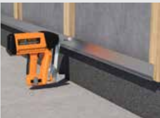
Montáž ventilačního soklového profilu
