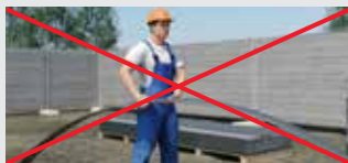
Fasádní obklady Hardie® VL Plank jsou vzájemně zastrčené do sebe. Palubky při odebrání z palety je nutno napřed vysunout a pak teprve zvedat.
