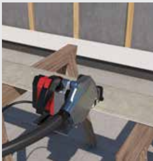
Pro přířezy používejte pilové kotouče vhodné na vláknocement (doporučení: Hardie™ Blade)
